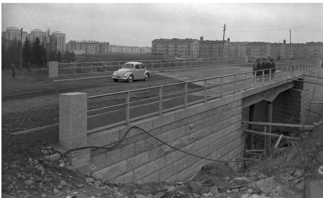
Kalevantien silta lokakuussa 1953. Kuvan etualalla näkyy vielä Kalevantielle nousseen aiemman kulkuyhteyden pengerrystä. Kuvan taustalla näkyy Kalevan tuolloin vielä melko uutta rakennuskantaa. Aamulehden arkistokuva, kuvaaja Ensio Kauppila. (Tampereen museoiden kuva-arkisto / Siiri- kuvapalvelu)
